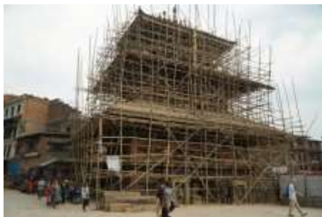
Bhaktapur Durbar Square (Đang trùng tu)
