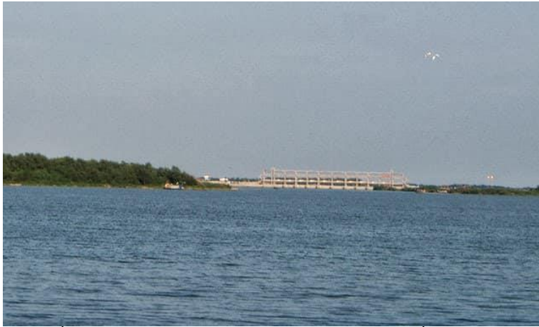
Hình 8: Cổng đập Ba Lai ngăn dòng sông Ba Lai. Tường cũng nên nhắc lại, vào năm 1999, nhà cầm quyền Cộng Sản VN cho xây dựng cổng đập Ba Lai để chặn dòng sông Ba Lai. Như vậy là kể từ đó Cửa Ba Lai bị đóng lại. Công trình xây dựng này hoàn thành ngày 30 tháng 4 năm 2002. Vậy là kể sau năm 2002, sông Cửu Long chỉ còn 7 cửa., ảnh 2015.
