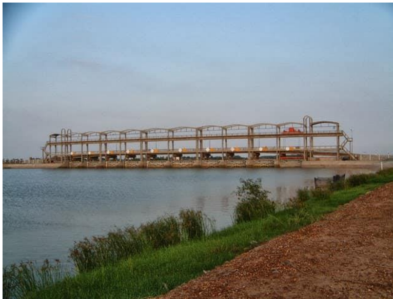
Hình 9: Cổng đập Ba Lai ngăn dòng sông Ba Lai. Tường cũng nên nhắc lại, vào năm 1999, nhà cầm quyền Cộng Sản VN cho xây dựng cổng đập Ba Lai để chặn dòng sông Ba Lai. Như vậy là kể từ đó Cửa Ba Lai bị đóng lại. Công trình xây dựng này hoàn thành ngày 30 tháng 4 năm 2002. Vậy là kể sau năm 2002, sông Cửu Long chỉ còn 7 cửa., ảnh 2015.
