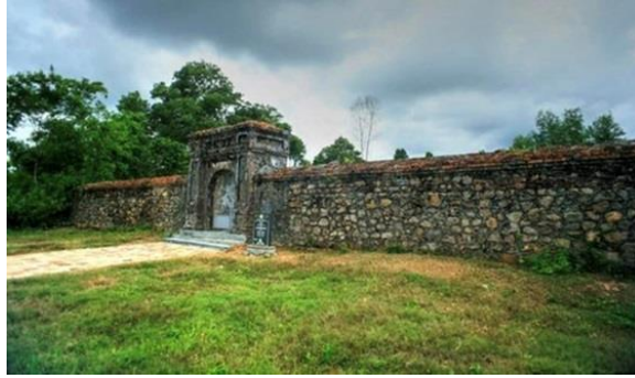
Hình 14: Lũy có hai vòng thành hình chữ nhật bao bọc. Vòng ngoài xây bằng đá bazan với phần mũ tường xây bằng gạch vồ, có chu vi 156,5m, cao 2,6m. Cổng chính của lũy được mở ở mặt thành hướng chính Bắc.
