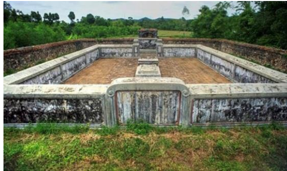
Hình 15: Vòng thành trong xây hoàn toàn bằng gạch vồ, chu vi 70m, cao 2m, mặt Bắc có hai trụ cổng dẫn vào mộ.
