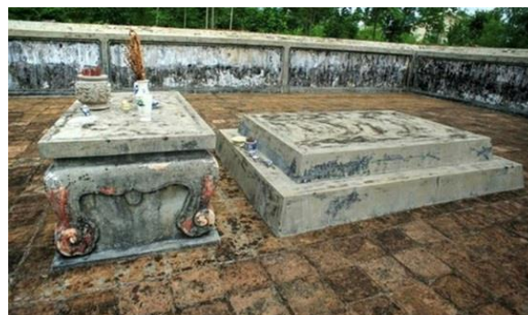
Hình 17: Mộ chúa Nguyễn Hoàng được xây bằng gạch vồ và vôi vữa gồm 2 tầng, hình khối chữ nhật. Tầng trên rộng 172cm, dài 248cm, cao 25cm. Tầng dưới rộng 222cm, dài 303cm, cao 30cm.
