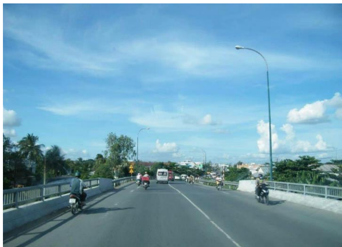
Hình 3: Cầu Cái Côn (trên đường từ Vĩnh Long đi đến cầu Mỹ Thuận).
