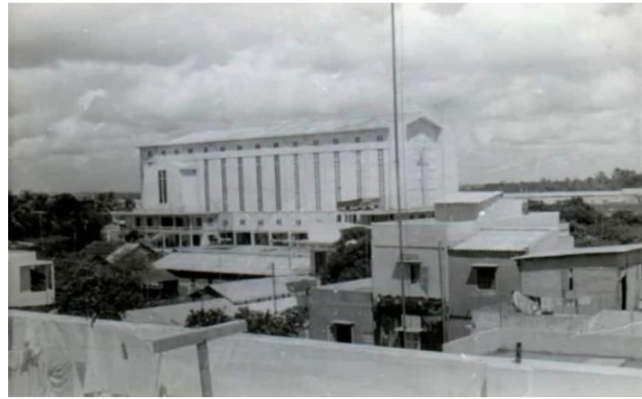
Hình 5: Nhà thờ Chánh Toà Vĩnh Long, trên đường Lê Thái Tổ, 1967.
