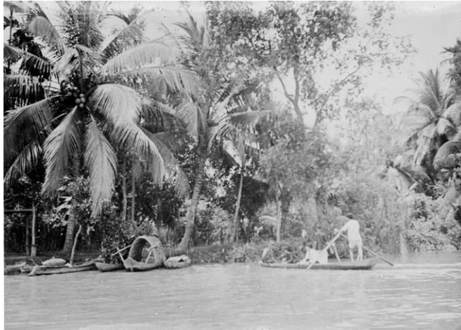
Hình 3: Vùng sông nước Trà Ôn 1920.
