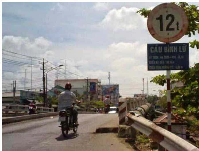
Hình 5: Cầu Bình Lữ 2015.
